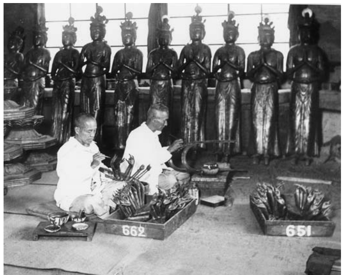
京都・三十三間堂、木造千手観音立像 昭和20年代の修理風景
