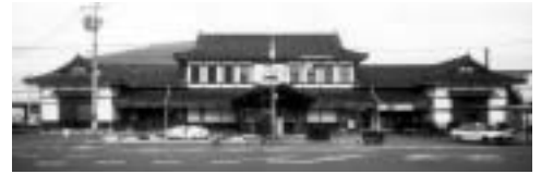
図6 旧二条駅舎（移築・解体前）
