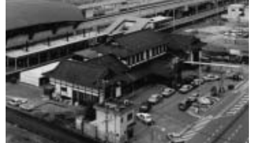
図7 旧二条駅舎（移築・解体前）
