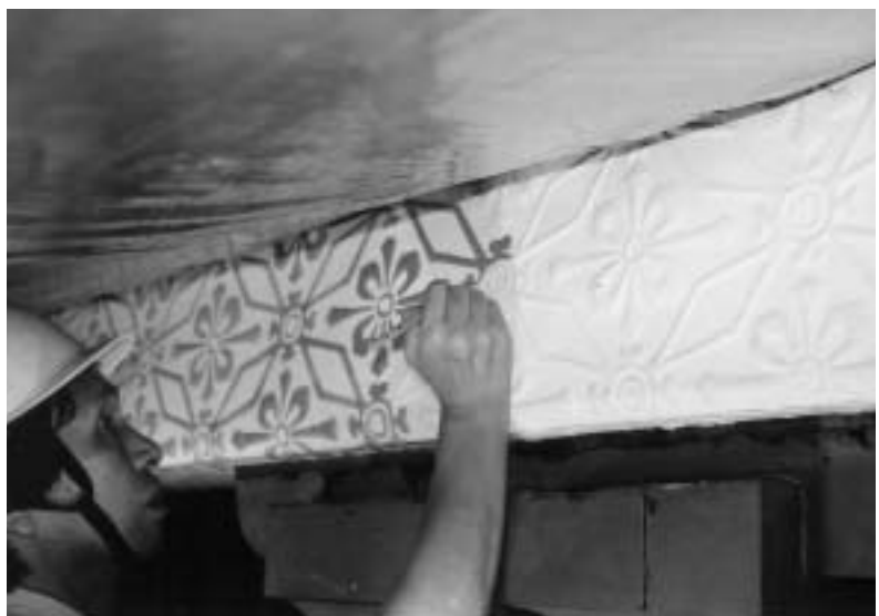
図1 重要文化財東照宮中神庫復元修理。丸桁、箔下塗施工
