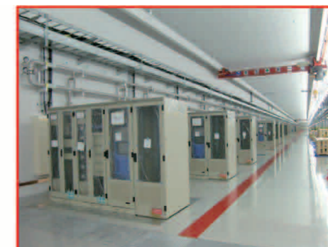
加速器を駆動し制御する機器類は、ユニット毎のラックに収納され、加速器に沿って設置される。
